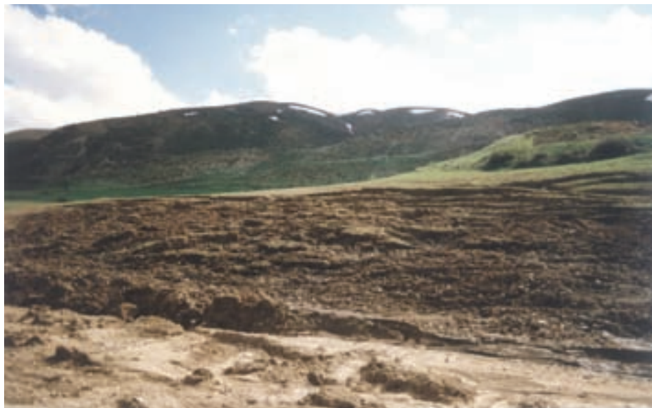
شکل ۲- لغزش شدید خاک؛ جاده‌ی پیرانشهر - سردشت
