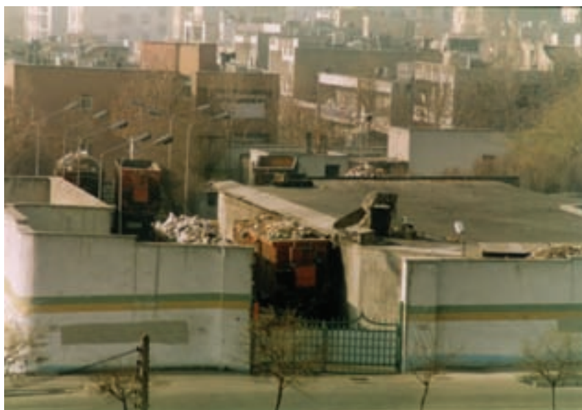
شکل ۹- احداث محل جمع‌آوری موقت زباله در میان یک منطقه‌ی مسکونی
