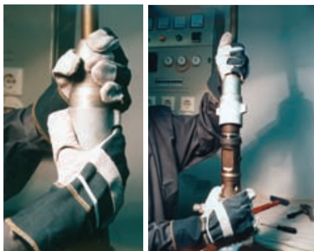
شکل ۲۶-۳- نحوه بستن ته سیلندر (سرپیک)
