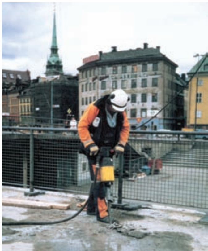
شکل ۳۸-۳- نحوه‌ی کار با انواع پیکور
