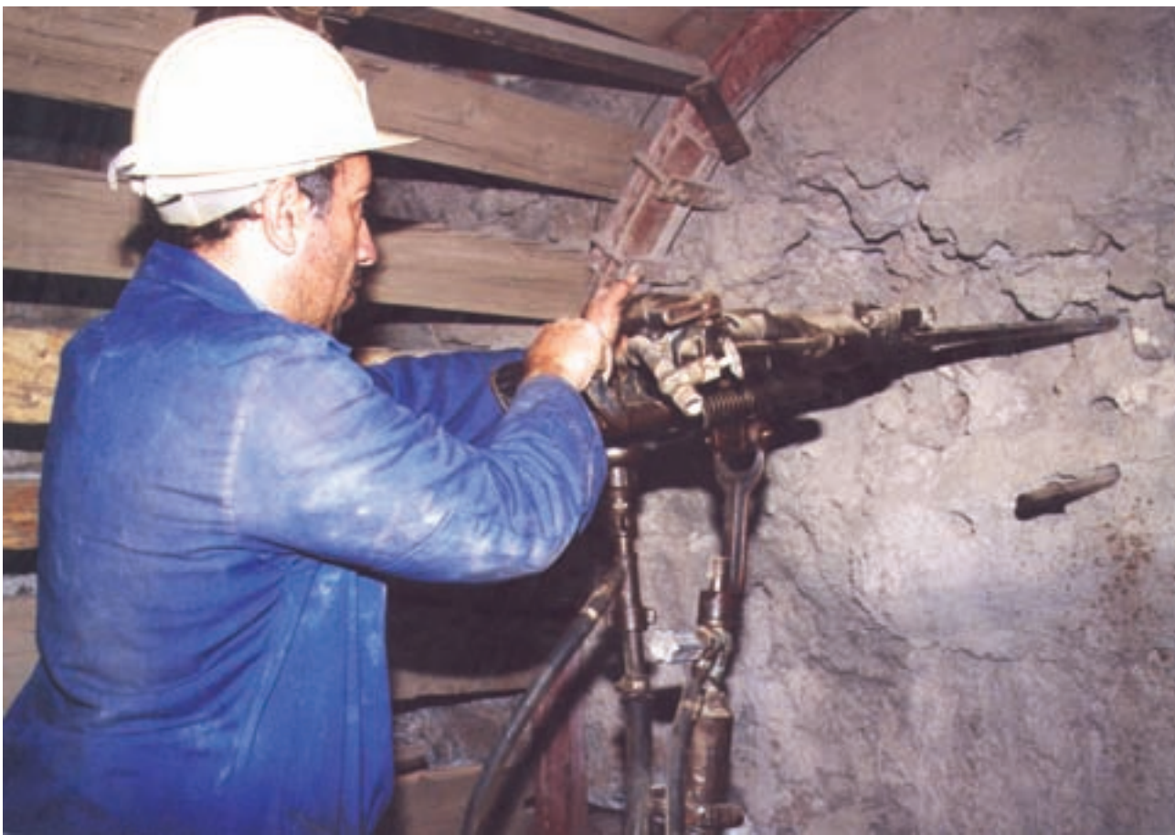
شکل ۲۷-۲- نحوه‌ی به‌کارگیری پرفوراتور
