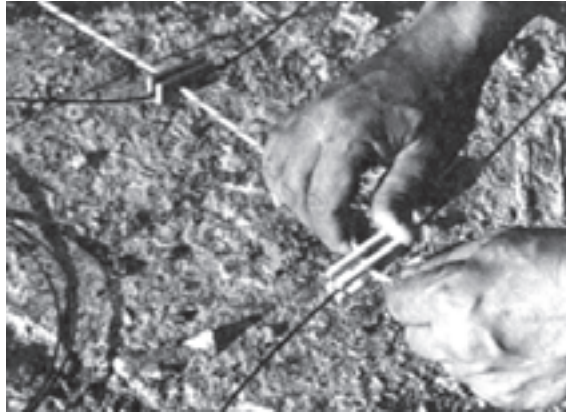
شکل ۱۷-۵- گیره اتصال فتیله انفجاری به نانل Multi Clip
