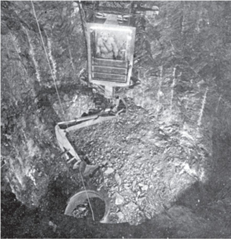
شکل ۱۰-۱۲- بارکننده قاشقی در چاه
