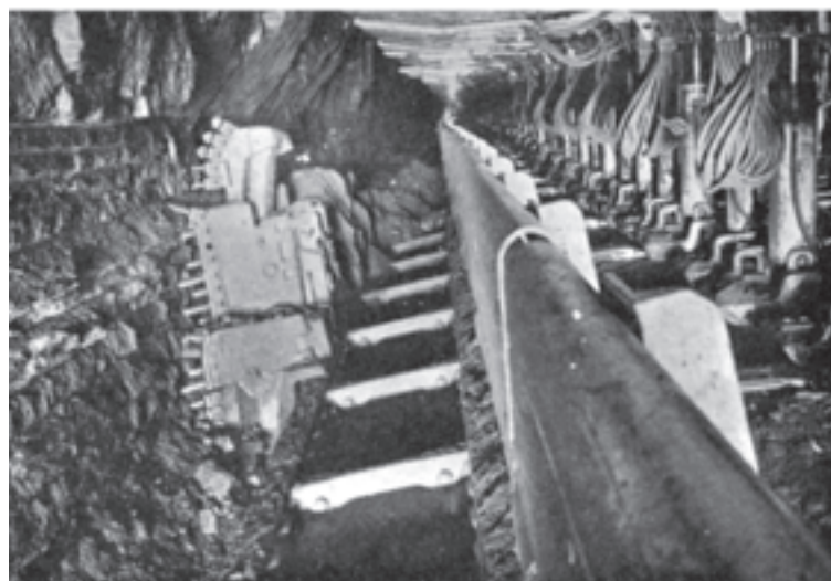
شکل ۱۱-۶- دو منظره از کاربرد ناو زنجیری در کارگاه استخراج زغال
