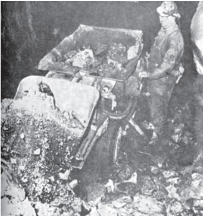
شکل ۱-۲- طرز کار بارکننده مکانیکی
