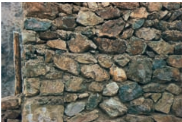
شکل ۶-۲۰- نمایش دیوار لاشه چینی با ملات
