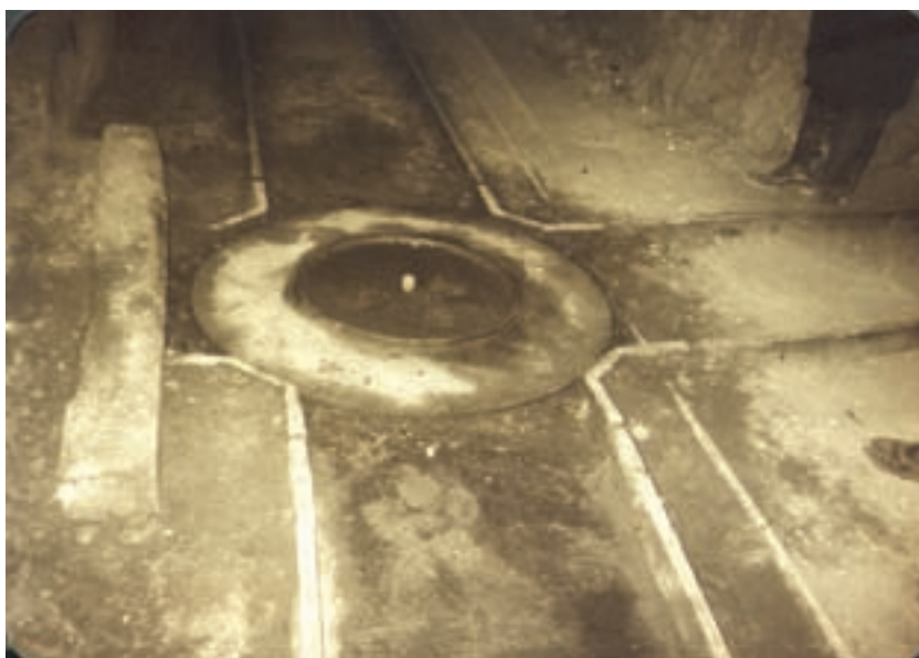
شکل ۱۲- ۳۱- سینی تقاطع در محل سه‌راهی و ریل‌های عمود بر هم
