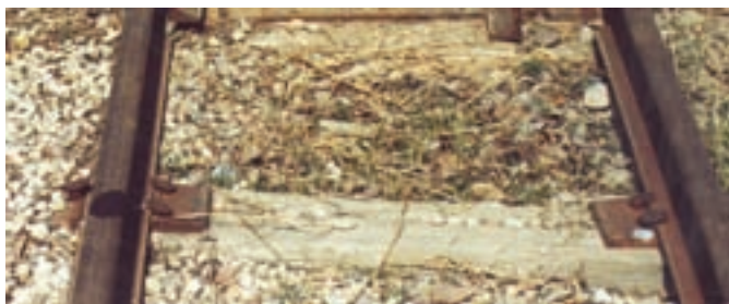
شکل ۳-۳۱- اتصال ریل به تراورس چوبی
