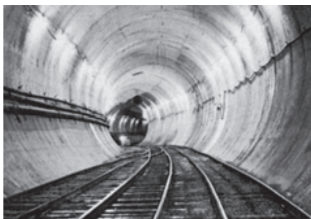
شکل ۱۳-۳۱- ریل‌گذاری در داخل تونل
