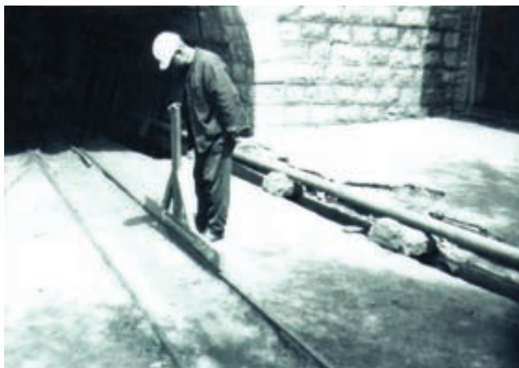
شکل ۸-۳۱- کارگر در حال اجرای روش واترپاس
