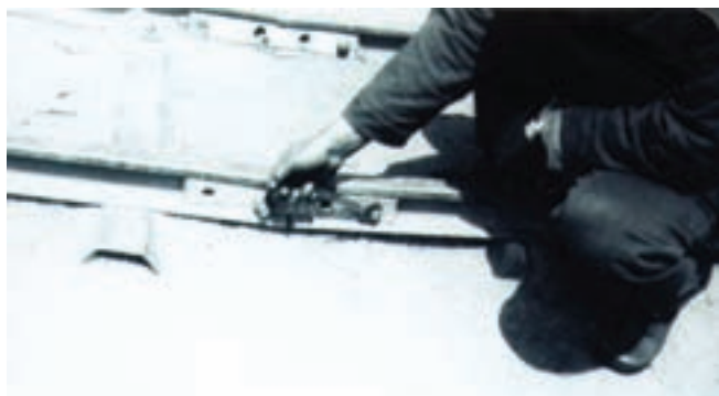
شکل ۵-۳۱ کارگر در حال بستن بغل‌بند
