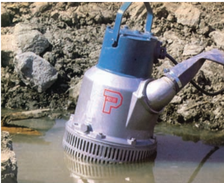
شکل ۱۶-۲- پمپ آبکشی در حال پمپاژ آب سطحی
