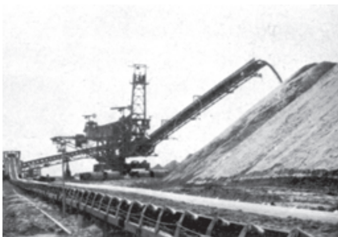
شکل ۳۱-۲ جابه‌جایی باطله توسط نوار نقاله
