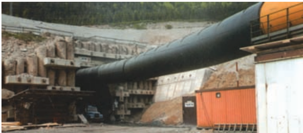
شکل ۱۳-۹- آویز جهت نصب لوله‌های تهویه
