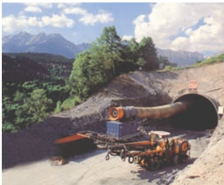
۱۴-۹- لوله‌های فلزی تهویه با اتصال جوشکاری شده
