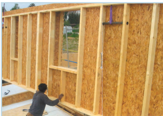
شکل ۱-۴ دیوار پیش ساخته چوبی در حین نصب
