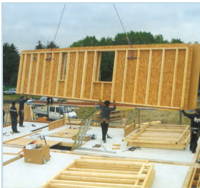
شکل ۱-۳ سوار کردن قطعات پیش ساخته در ساختمان
