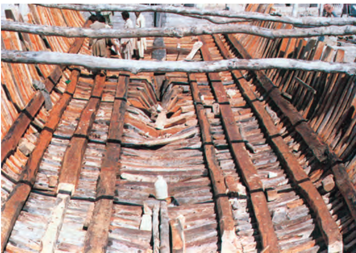
شکل ۱۳-۲- نصب تیرهای طولی روی فریم‌ها
