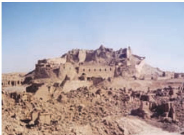
ب) ارگ بم بعد از زلزله
