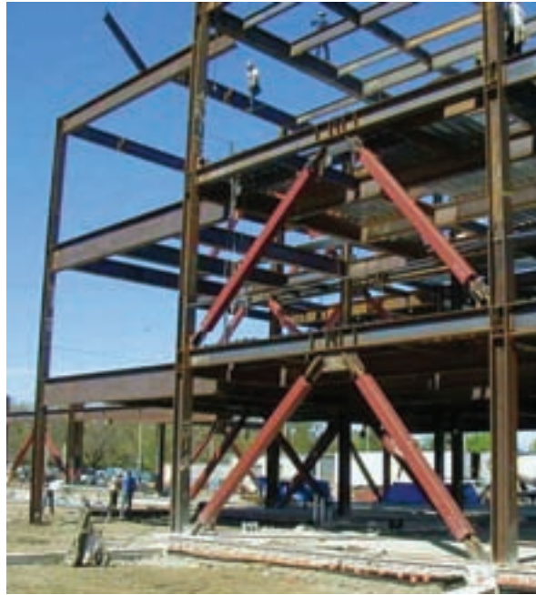
شکل ۵۰-۳- مقاوم سازی ساختمان‌ها در مقابل زمین لرزه
