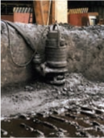
شکل ۹-۵- نصب پمپ کف کش در جاله
