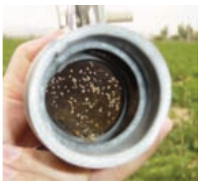
شکل ۱۸-۷- صافی (فیلتر) در مسیر لوله نیمه اصلی
