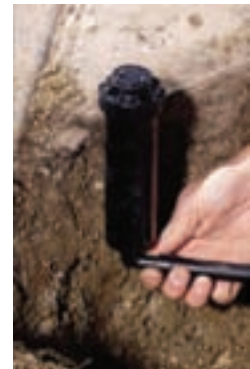
د) نصب آب پاش
