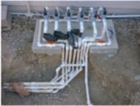
ب) نصب شیرهای برقی و فیلتر روی زمین
