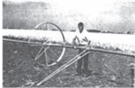
الف) نصب جک تثبیت روی لوله‌ها
