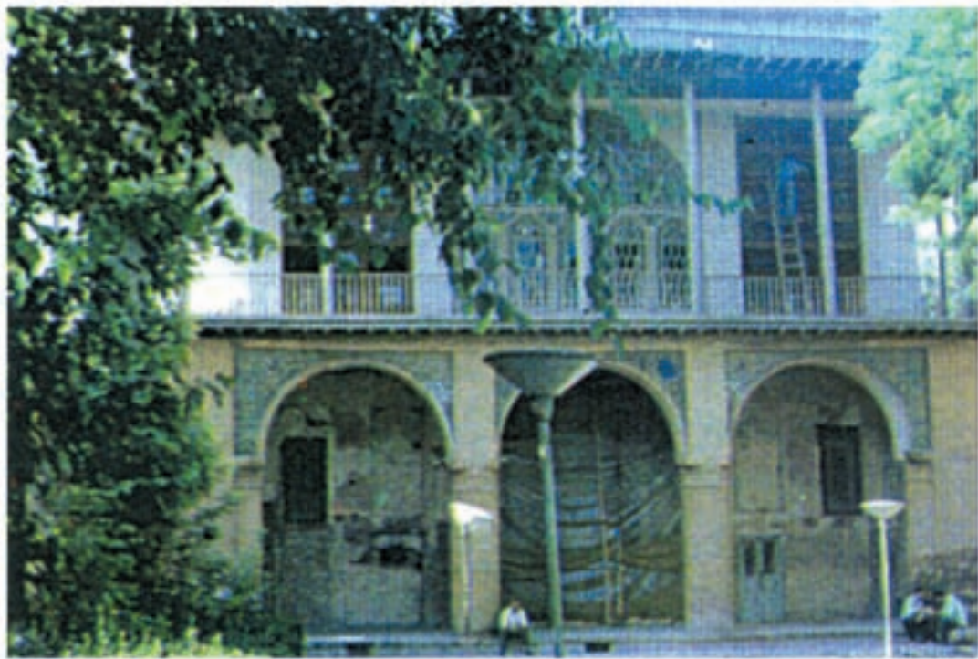
شکل ۱۲۱- عمارت چهلستون قزوین
