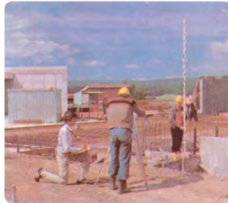
شکل ۱۴-۸- طریقه‌ی نگاه داشتن میر
