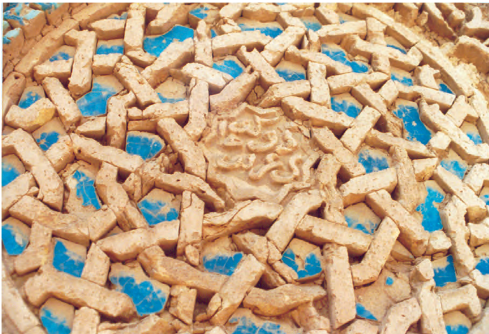
شکل ۲-۷- نقوش هندسی در آجرکاری گناباد - مسجد ملک زوزن - ۶۰۰ ه. ق
