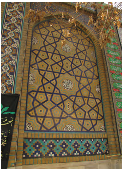
شکل ۳-۴۸ - گره کُندِ سرمه‌دان چهارشمسه شمسه - نمای بیرونی - بنای گنبد سبز
