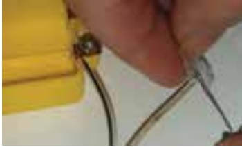
شکل ۵-۲- عایق‌بندی اتصال‌ها با نوارچسب شفاف
