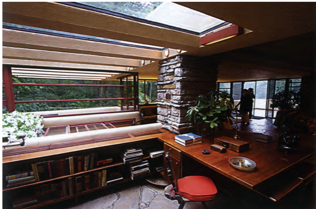
تصویر ۸-۴- نورگیر سقفی در فضای داخلی
