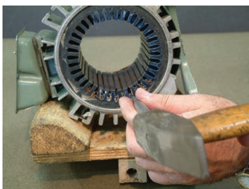
شکل ۲-۲۳ - هدایت سیم‌ها به طرف دوم استاتور
