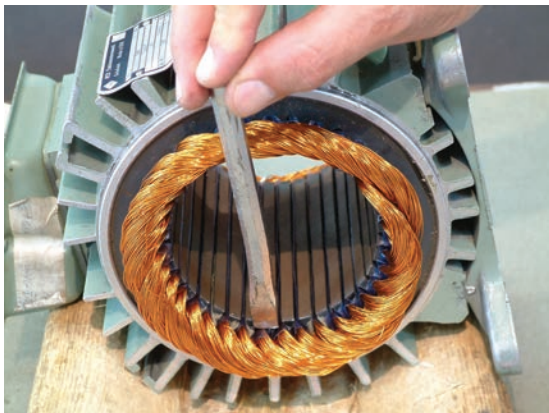
الف - قرار دادن قلم روی سیم‌ها
