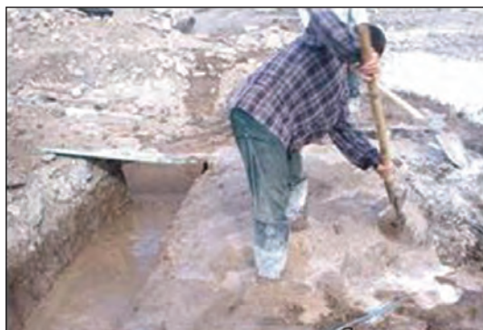
شکل ۳-۳۷ اجرای شفته آهک در فونداسیون
