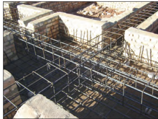
شکل ۳-۱۳۵ عبور میلگردهای شناژ در پی
