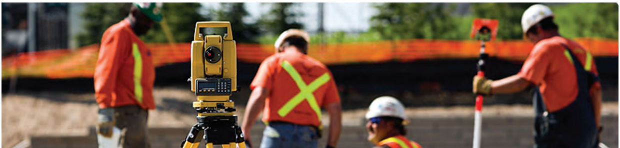
شکل ۴-۱. پیاده کردن با دوربین نقشه‌برداری
