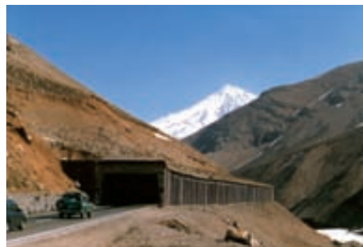
شکل ۲۷-۶ - دو نوع بهمن گیر در جاده هراز، راهی برای مقابله با خطر بهمن
