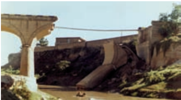
شکل ۱۷-۶- تخریب یک پل ارتباطی بر اثر سیل
