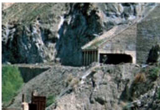
شکل ۲۷-۶ - دو نوع بهمن گیر در جاده هراز، راهی برای مقابله با خطر بهمن
