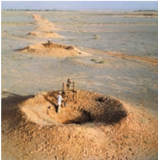
شکل ۹-۱۱- قنات در نواحی خشک از ابداعات قدیمی ایرانیان برای بهره‌برداری از آب‌های زیرزمینی.
