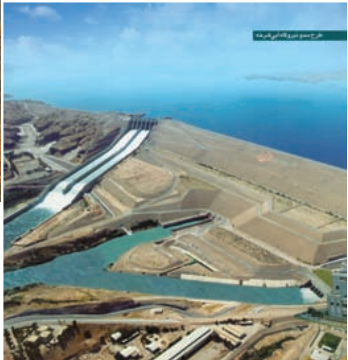
شکل ۹-۱۲- سد و نیروگاه آبی کرخه شیوه‌ای نو برای بهره‌برداری از آب‌های سطحی
