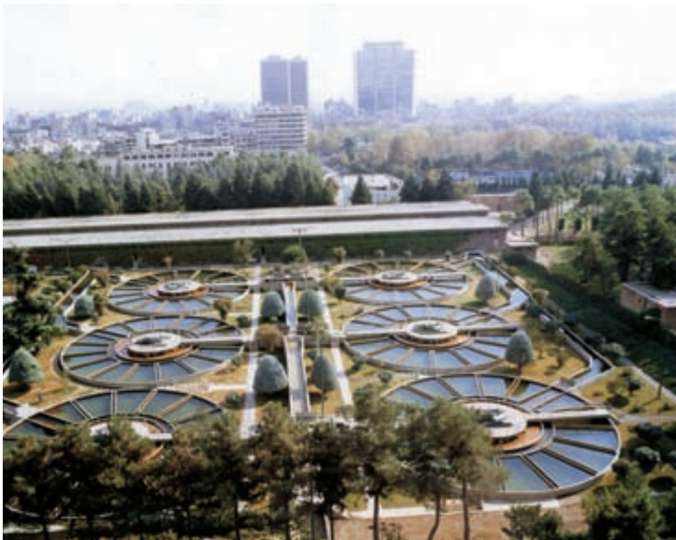
شکل ۱۴-۹- تصفیه‌خانه‌ی شماره‌ی ۲ آب تهران - جلالیه
