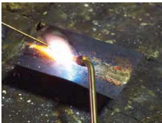
شکل ۴-۷- ایجاد گاز در اطراف محل لحیم کاری
