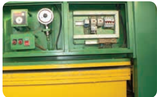
شکل ۵-۹۸ تابلوی فرعی برق نصب شده روی پرس
