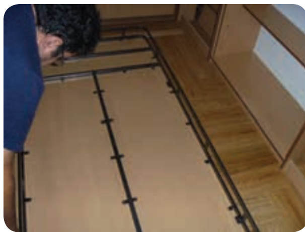
شکل ۵-۷ کفی محل استقرار تشک روی کلاف فلزی
