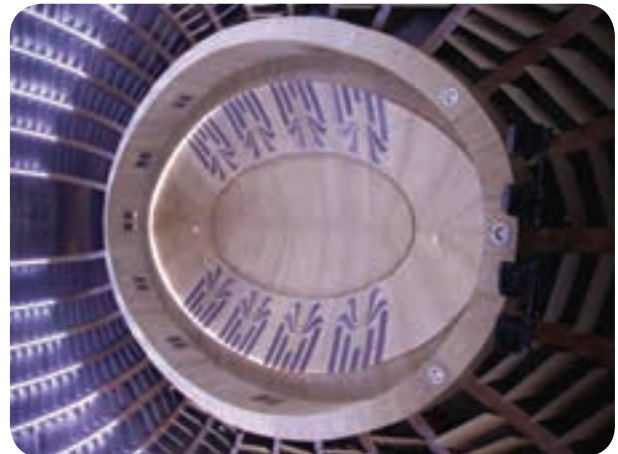
شکل ۱۱۵-۵ قسمتی از سقف که با سیستم پنوماتیک باز و بسته می شود
