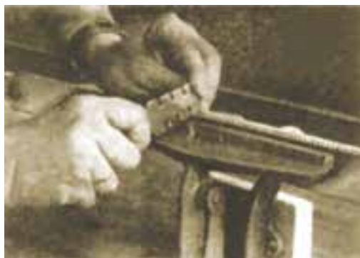
شکل ۱۴-۵۲- چپ و راست کردن ارّه با آهن چپ و راست کن.
