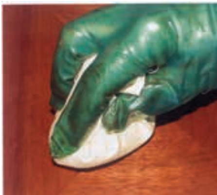
شکل ۵-۸- زدن سیلر با کهنه رنگ‌کاری.
