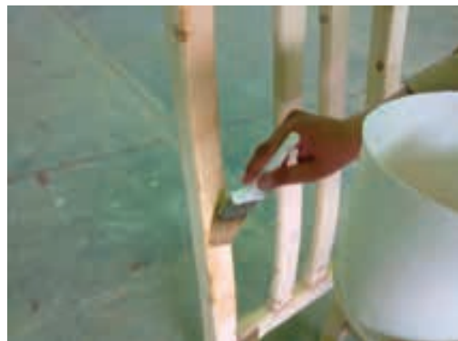
شکل ۳۶-۸- سیلکاری از سمت بالا به سمت پایین.
