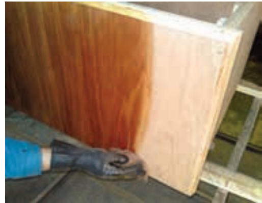
شکل ۳۱-۸- زدن آستری هم‌رنگی از پای به بالا.
