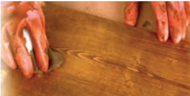
شکل ۴-۸- زدن آستری هم‌رنگی با پارچه رنگ‌کاری.
