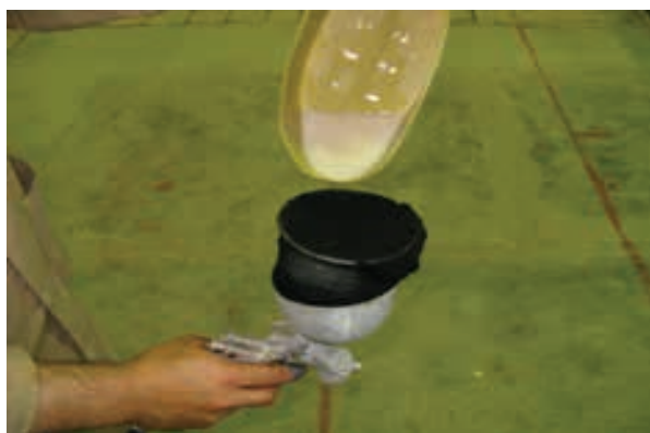
شکل ۵-۹- استفاده از جوراب نازک به عنوان صافی.
