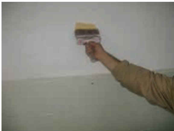
شکل ۴۰-۱۳- زدن رنگ پلاستیکی به دیوار با قلم‌موی ساختمانی.
