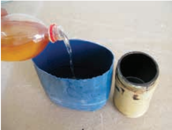
شکل ۴۴-۱۲- رقیق کردن آستری قیری با بنزین.
