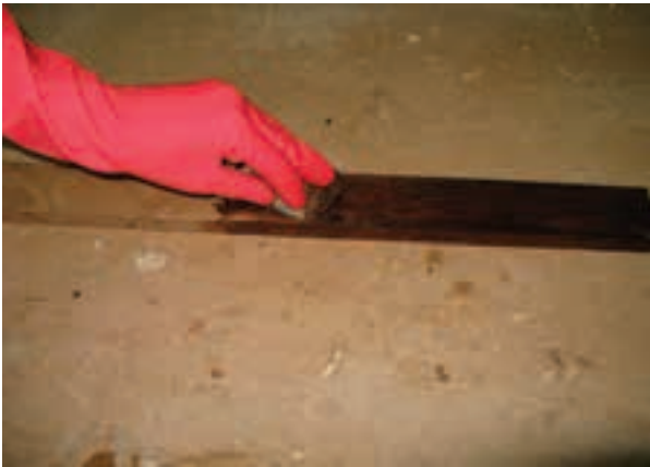
شکل ۶۵-۱۳- آسترکاری چوب راش.
