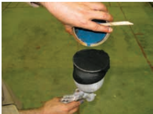
شکل ۲۲-۱۱- صاف کردن رنگ با استفاده از جوراب نازک.
