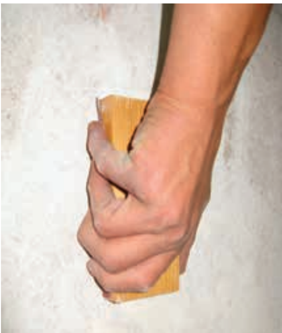
شکل ۱۹-۱۱- سنباده‌کاری سطوح ماستیک‌کاری شده.
