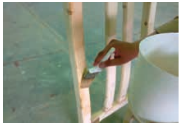
شکل ۴۷-۱۲- زدن آب روی گره قبل از آستری زدن.
