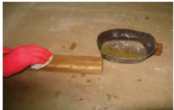
شکل ۳۸-۱۳- سیلرکاری با کهنه رنگ‌کاری.
