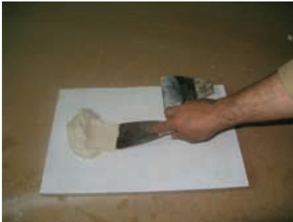
شکل ۱۸-۱۱- ماستیک‌کاری سطح کار.
