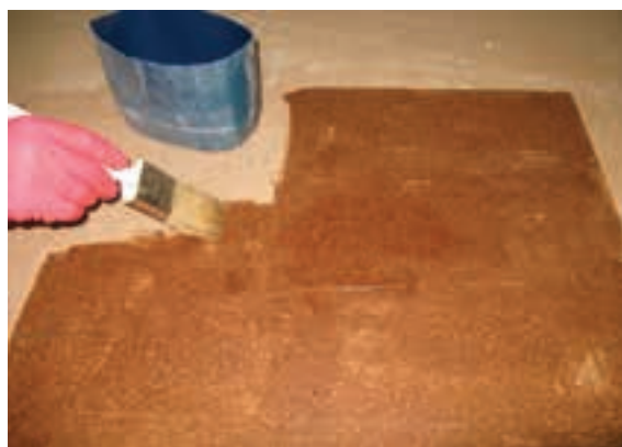
شکل ۴۹-۱۳- روغن اندود کردن سطح کار.
