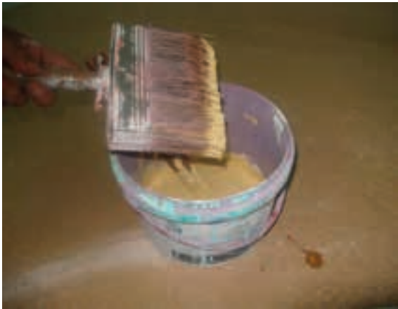
شکل ۵۶-۱۳- رنگ‌کاری دیوار با قلم‌موی ساختمانی.
