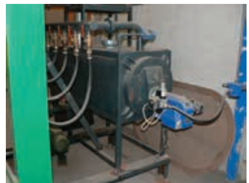
شکل ۱۱۹-۱۵- کنترل مشعل و دیگ داغ‌کننده روغن.
