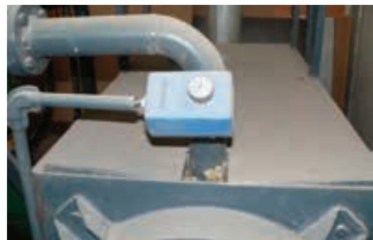
شکل ۱۲۹-۱۵. حرارت سنج (روی دیگ روغن پرس روغنی).
