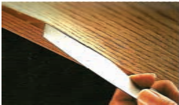
شکل ۱۳-۱۷- باز کردن دهانه (روکش با کاردک).
