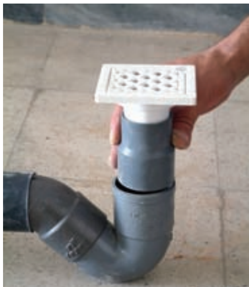
شکل ۳-۱۹- اتصال کف‌شوی به وسیله‌ی تبدیل
