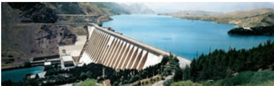
شکل ۲۶-۶- احداث سد روشی برای کاهش خطر خشک‌سالی
