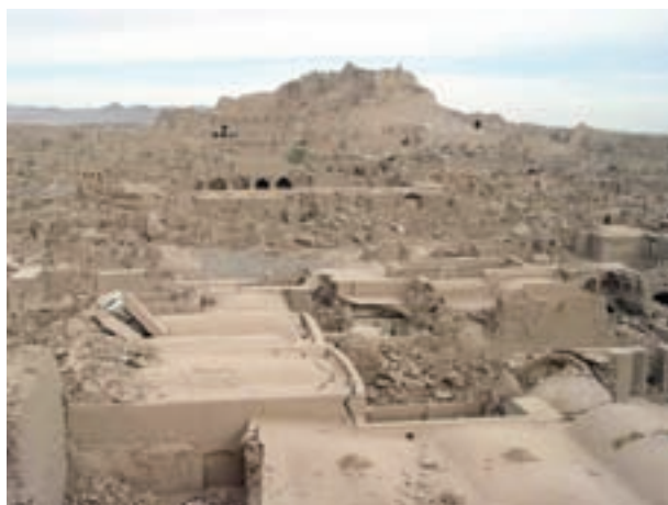
ب- ارگ بم بعد از وقوع زلزله
