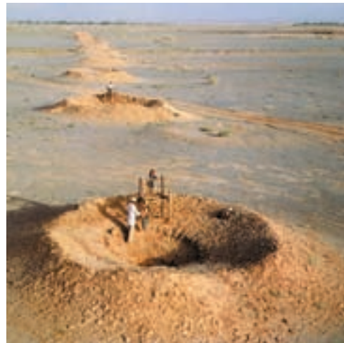
شکل ۹-۹- قنات در نواحی خشک از ابداعات قدیمی ایرانیان برای بهره‌برداری از آب‌های زیرزمینی
