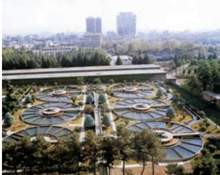
شکل ۱۲-۹- تصفیه‌خانه‌ی شماره ۲ آب تهران - جلالیه
