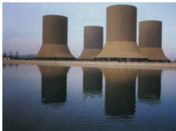
شکل ۹-۱۴- استفاده مجدد از آب مصرفی در نیروگاه‌ها (نیروگاه شهیدرجایی - قزوین)
