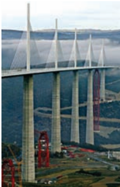
پل کابلی با پایه‌های بتنی
