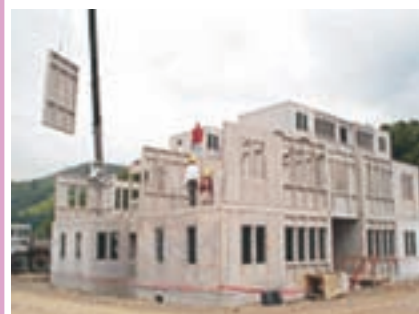
اجرای ساختمان پیش ساخته بتنی
