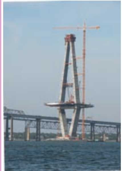
پایه‌ی بتنی یک پل کابلی
