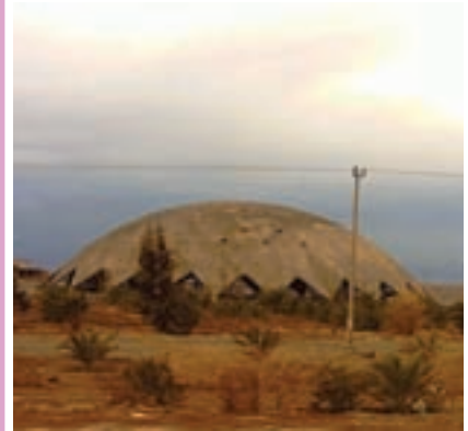
یک سازه‌ی پوسته‌ای بتنی که در زلزله‌ی بم کاملاً سالم مانده است.
