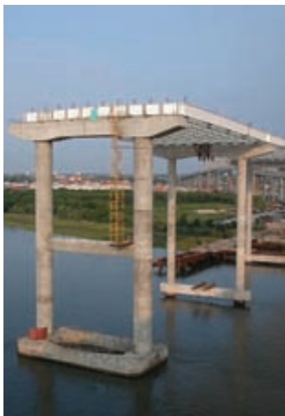
پایه‌های بتنی یک پل
