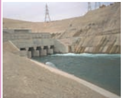
کانال بتنی آب
