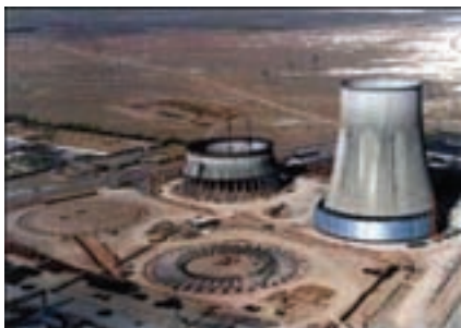
برج‌های خنک‌کننده‌ی نیروگاه برق اصفهان در حین ساخت
