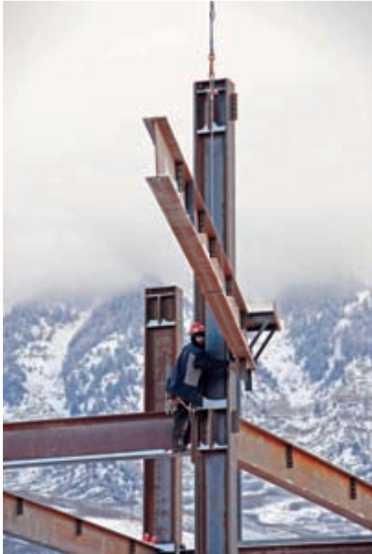
اجرای اسکلت فولادی در ارتفاع
