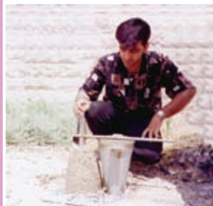
اجرای آزمایش اسلامپ برای تعیین میزان کارآیی بتن
