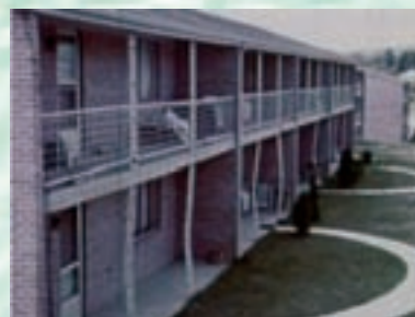
نمونه هایی از کمانش کلی ستون
