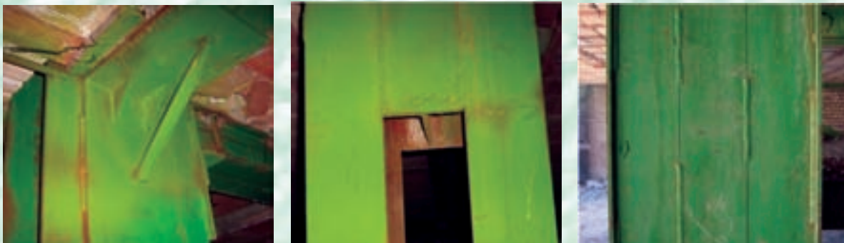
ستون با مقطع مرکب سه تایی در محل اتصال خمشی و ورق تقویتی روی بال آن
