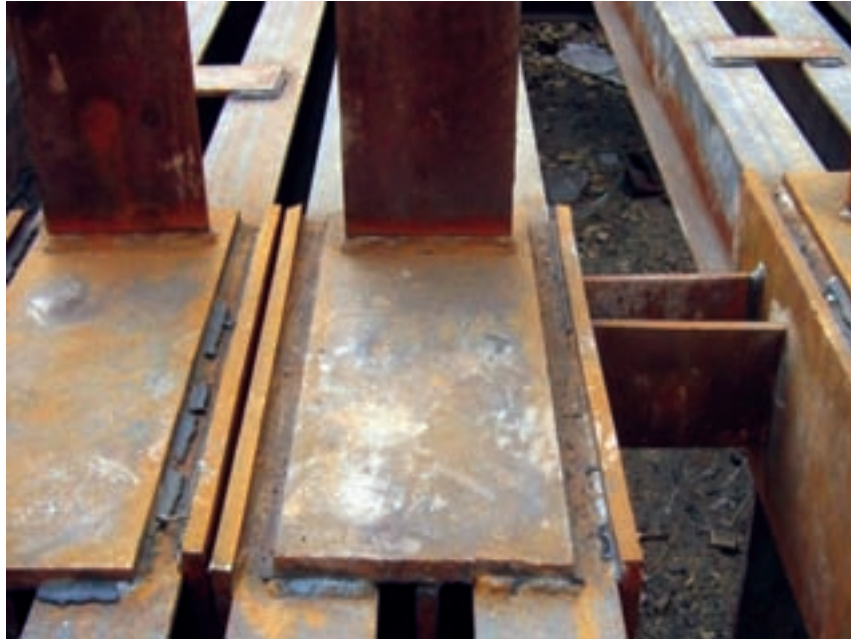
شکل ۴-۲۳- جزئیات ورق اتصال در قاب‌های خمشی
