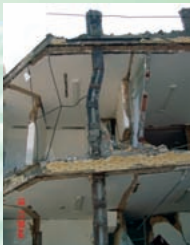
نمونه هایی از کمانش کلی ستون
