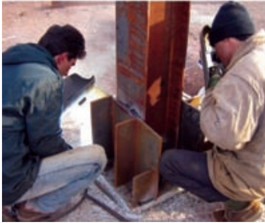
شکل ۴-۲۶- جوشکاری کامل پای ستون و مملقات آن
