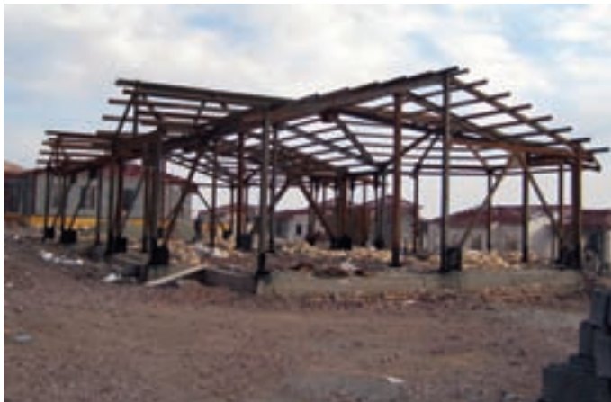
شکل ۴-۲- نمونه اسکلت فولادی شامل اعضای فشاری
