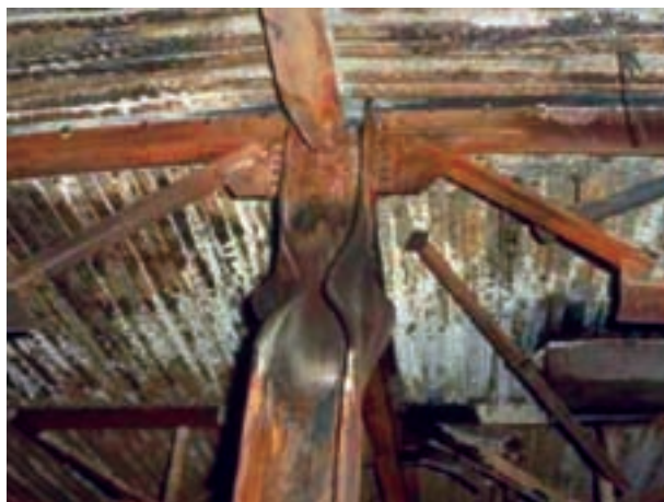
شکل ۴-۵- کمانش موضعی ستون
