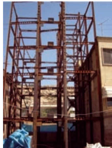
شکل ۴-۱۷- ستون دابل با ورق تقویتی
