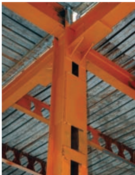
شکل ۴-۲۱- اتصال تیر به ستون دابل پا باز
