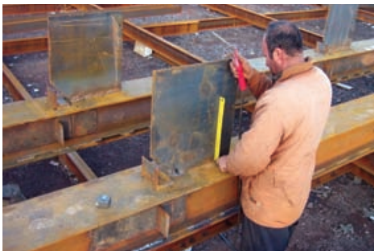
شکل ۴-۲۲- نصب ملامقات ستون روی شاسی‌های مونتاژ
