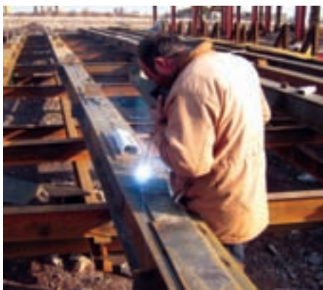
شکل ۴-۱۵- جوشکاری ستون جفت (وی شاسی کار)
