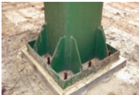
ت- پای ستون پس از سافت، نصب و گروت‌ریزی
