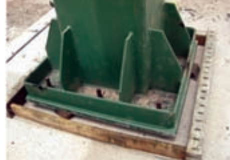
پ - نصب ستون و قالب بندی جهت گروت‌ریزی
