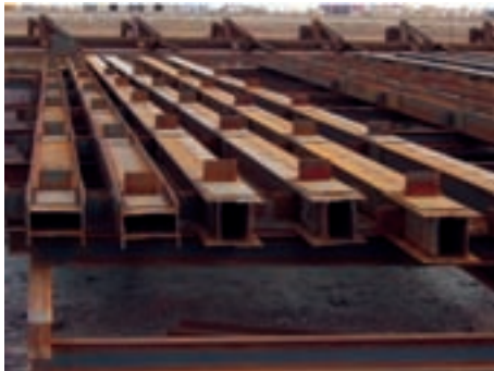
شکل ۴-۱۴- ستون با پروفیل جفت
