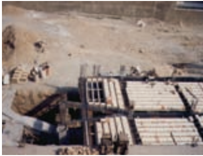
اجرای سقف تیرچه بلوک
