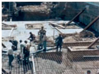
نمایی از فونداسیون نواری و مرکب از یک ساختمان مسکونی در حال بتن‌ریزی
