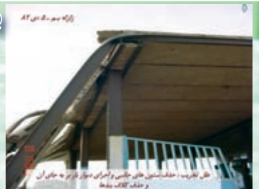
علل تخریب: حذف ستون‌های جانبی و اجرای دیوار باربر به جای آن و حذف کلاف بندها
