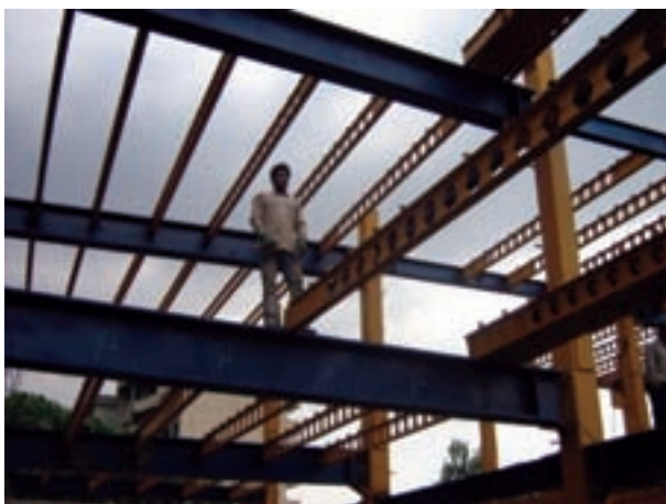
نصاب اسکلت در حال نصب تیرچه‌ها در سقف کامپوزیت
