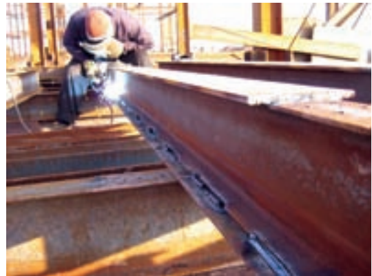
شکل ۵-۱۳- جوش‌کار در حال جوش‌کاری ورق تقویتی نیمرخ استاندارد تقویت شده
