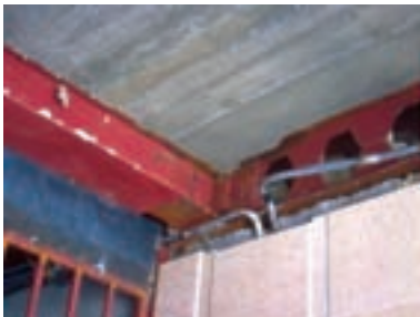
شکل ۵-۲۰- سافت تیرهای لانه زنبوری و نصب آن‌ها
