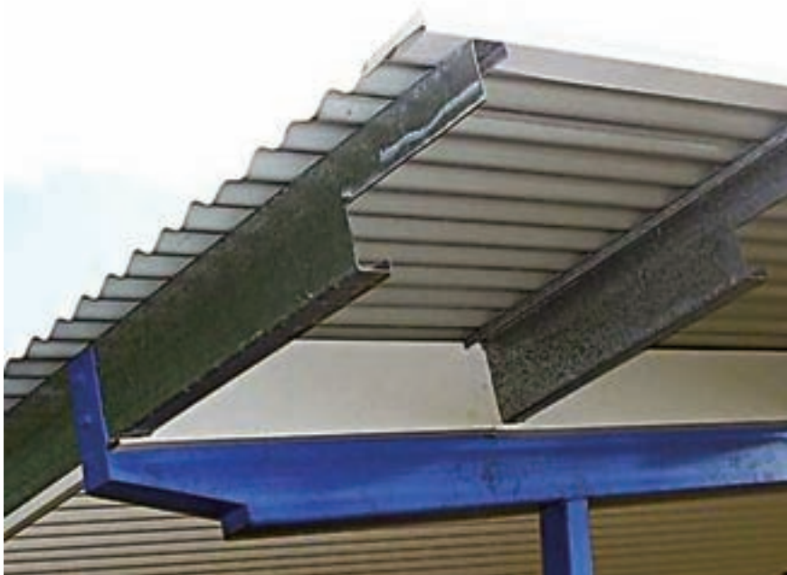
شکل ۵-۱۹- لایه جهت نصب پوشش در ساختمان صنعتی
