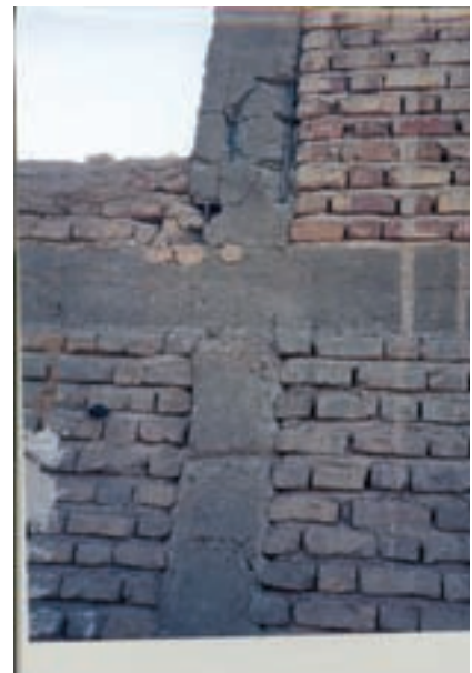
عدم رعایت پوشش بتنی مناسب بر روی میل‌گردها
