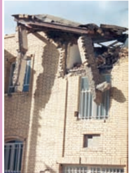
جدا شدن شنازهای قائم خربشته از سازه به دلیل ناکافی بودن طول وصله
