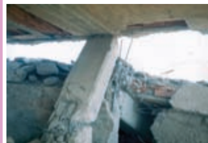
ضعف ستون و عدم اتصال صحیح به تیر بتنی موجب تخریب سازه شده است.
