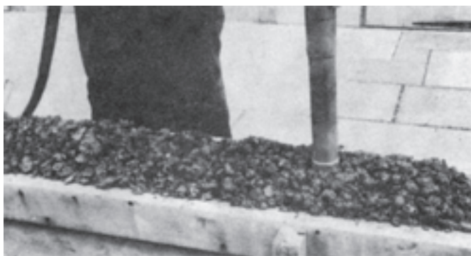
شکل ۶-۱۲- فرو بردن یک لرزاننده میله‌ای در داخل بتن تازه در یک قالب تیر
