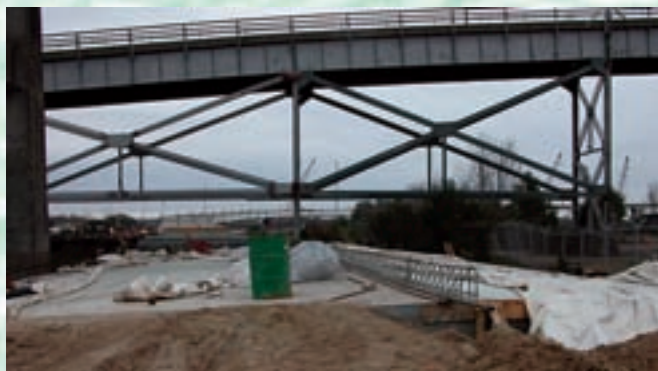
مهاربند های زیر عرشه ی پل برای مقاومت در برابر بارهای جانبی باد و زلزله
