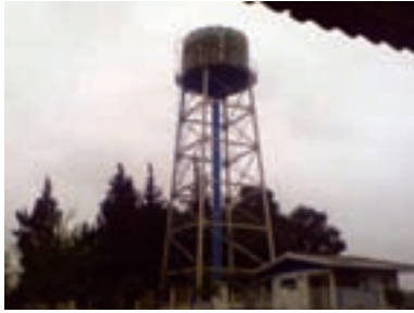
عضو کششی به عنوان مهاربند قطری نمونه‌هایی از اعضای کششی در سازه‌های مختلف
