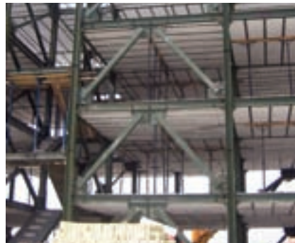
شکل ۹-۴- انواع مهاربند قائم در سافتمان
