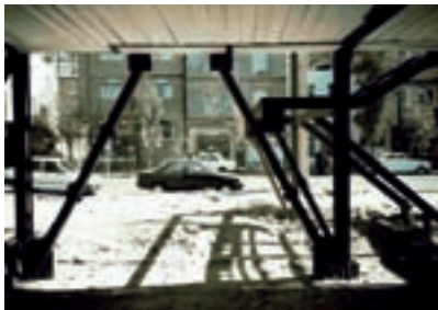
ب- مهاربند ذوزنقه واگرا در اسکلت فولادی
