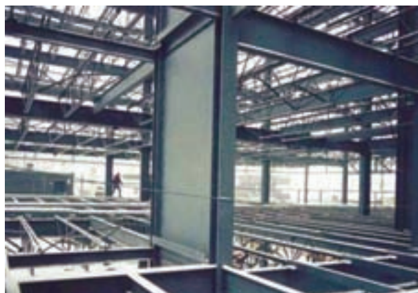
شکل ۹-۳- دیوار برشی بتنی در سازه فولادی
