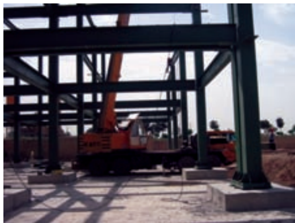
شکل ۹-۲- قاب فمثنی در سازه فولادی
