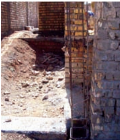
شکل ۹-۷- یک سافتمان با مصالح بنایی در حال سافت
