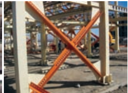
الف- مهاربندهای همگرا در اسکلت فولادی
