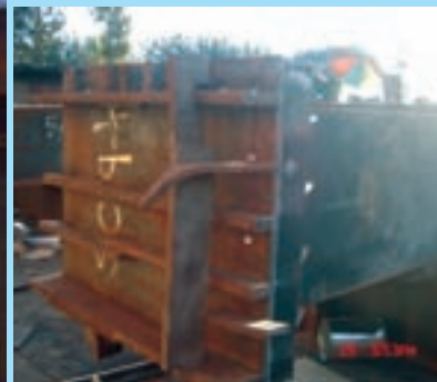
استفاده از مهار پشت‌بند جهت جلوگیری از تاب برداشتن ورق کف ستون در کارخانه
