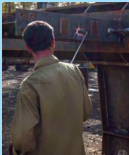
صاف کردن قطعات به کمک مارت
