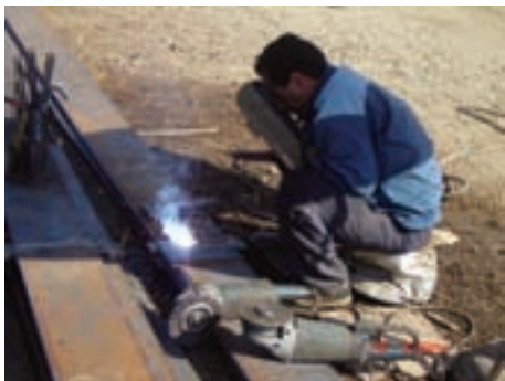
ب- جوشکاری روی درز
