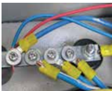
شکل ۳-۱۵ اتصال پیچی.
