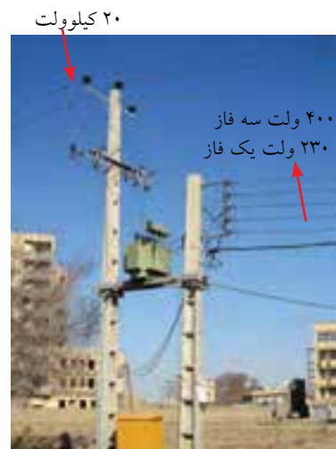
شکل ۱-۷ تبدیل ولتاژ ۲۰ کیلوولت به ۴۰۰ و ۲۳۰ ولت.
