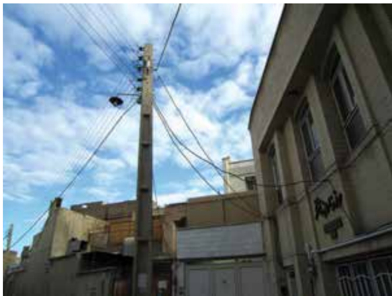
شکل ۱-۹ چگونگی اتصال برق منازل مسکونی.
